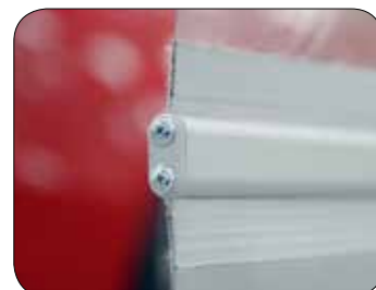
Aluminiumlist mellan de olika materialen förhindrar rynkbildning.
