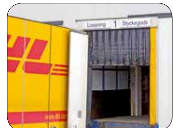
Använd en PVC-ridå med korta stripes vid exempelvis lastkajer för att skydda mot kalldrag.
