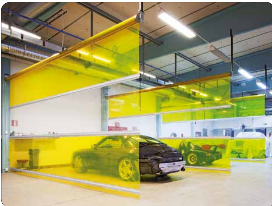
Motordrivna rulldraperier förhindrar spridning av smuts och slipsprut mellan arbetsplatser.
