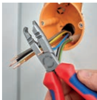
Klippning vid kortning av enskilda ledare
